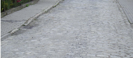
Kanalizacja sanitarna w ul. Polnej w Samotworze
