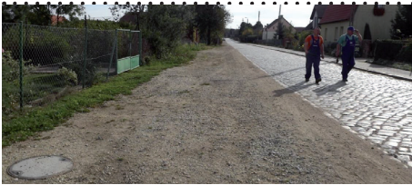
Kanalizacja sanitarna we Wszemilowicach
